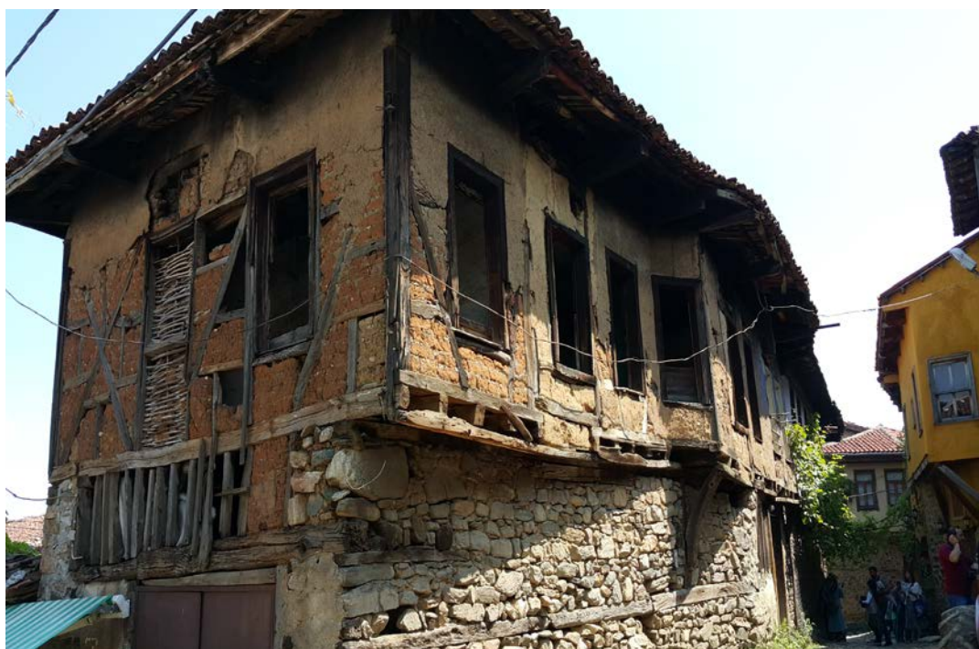
Fig. 10. Construction systems, hımış ( Cumalıkızık ).
