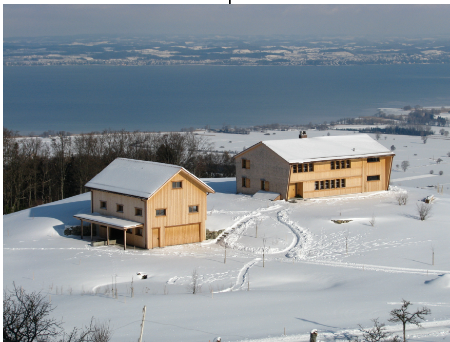
a - Casă cu anexă realizată din plăci stratificate din lemn masiv (s-au utilizat 300m 3 de lemn) / House and annex made of cross-laminated timber (300m 3 of solid wood were used).
