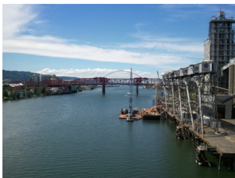
Vedere a Râului Columbia în traversarea Portlandului / View on Columbia River crossing Portland
